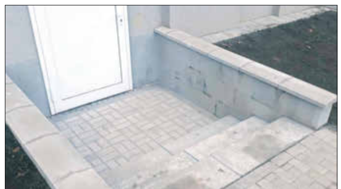
Erneuerter Eingang Sporthalle Güsen
