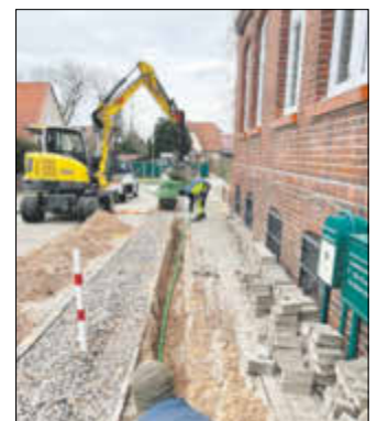
Schachtarbeiten vor der Gemeinde
