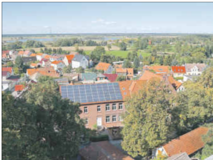
Solaranlage auf den Dächern der Gemeindeverwaltung Elbe-Parey
