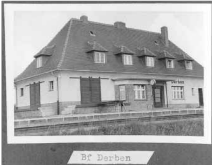
Bahnhof Derben, wurde am 8.4.1945 völlig zerstört
