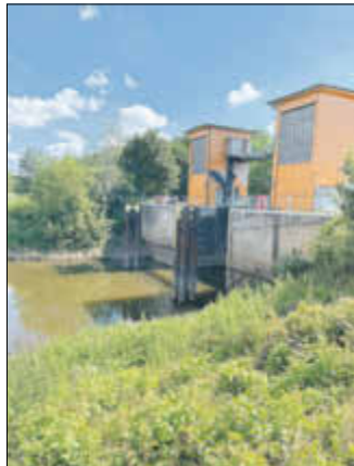
Die Zweistufenschleuse in Parey
